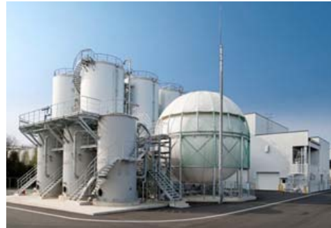
霧島酒造（株）焼酎粕リサイクルプラント及び発電施設
